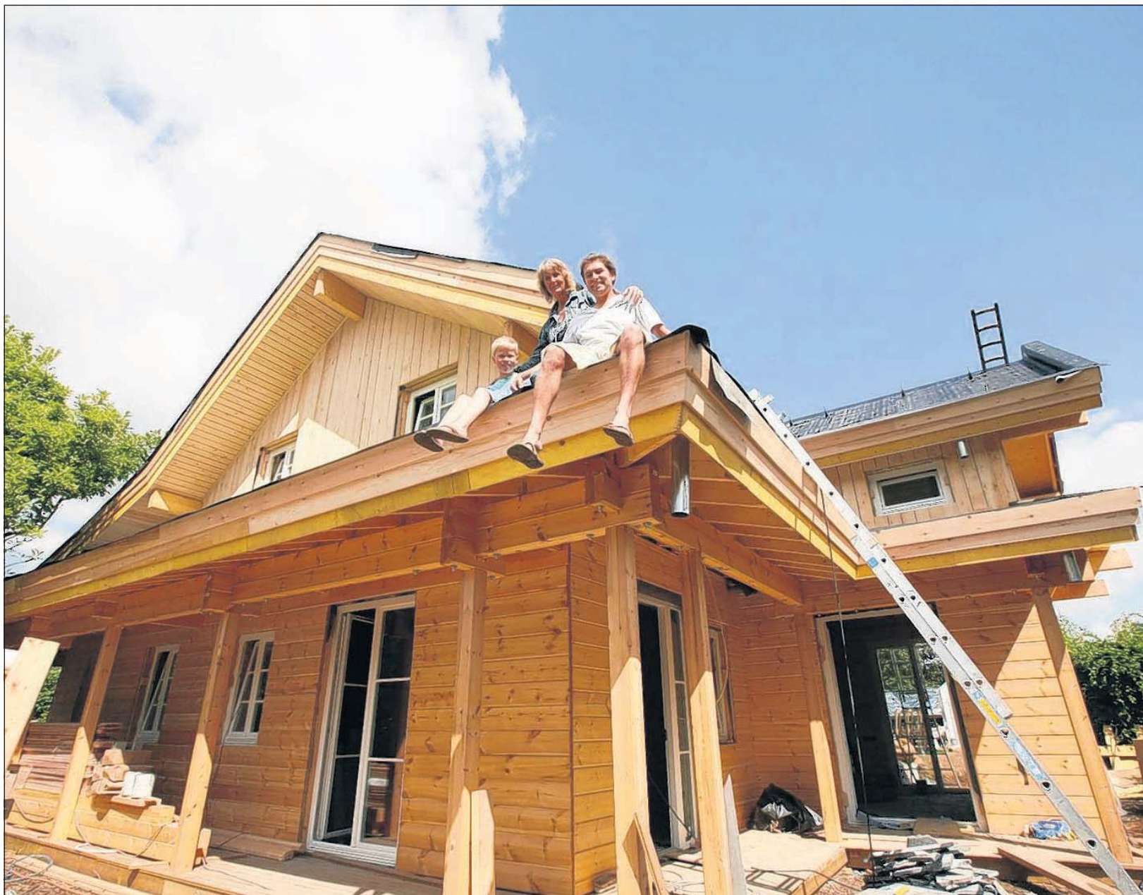
Het gezin Van de Poel op het dak van de ecowoning, die momenteel gebouwd wordt in de Vijlense buurtschap Rott.
